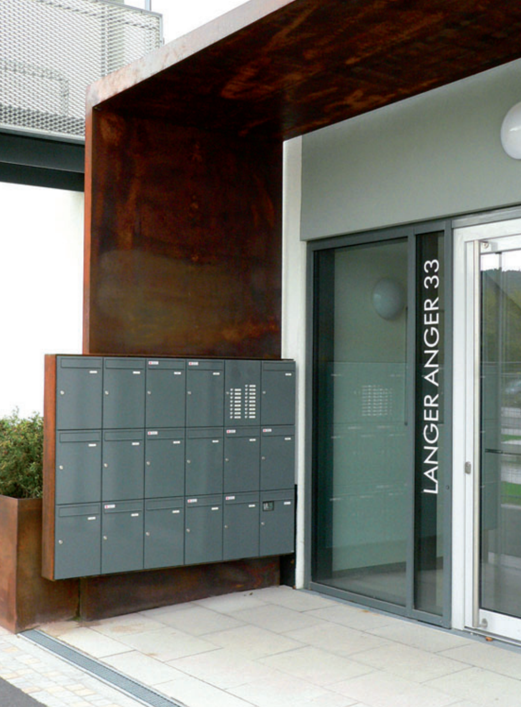
Sonderverkleidung 1cm Flachmaterial, Kästen Edelstahl
